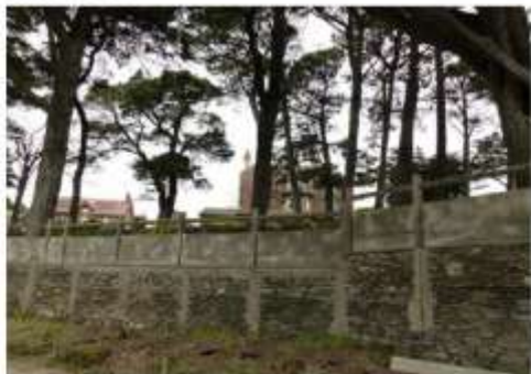
...Le mur en pierre surmonté d'une clôture en panneaux de béton, aujourd'hui
