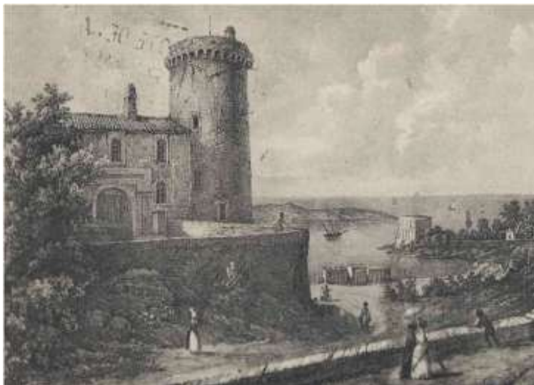
L'entrée du château depuis la vallée du Cracaud, la plage et la sortie du port vers 1845
