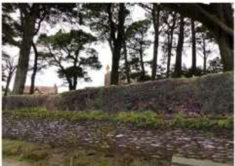
Simulation : ce que devait être ce mur de clôture face à la mer avant sa transformation (photo à droite)...
