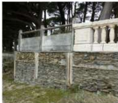
Jonction panneaux de béton et colonnades en pierre calcaire
