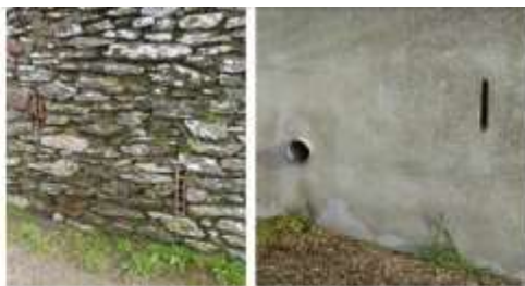
Les murs en pierre progressivement recouverts d'enduit ciment
