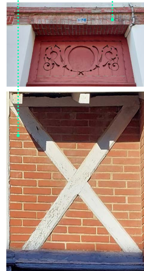
linteau en bois imitant un appareillage de briques Ossature charpentée et remplissage de briques
