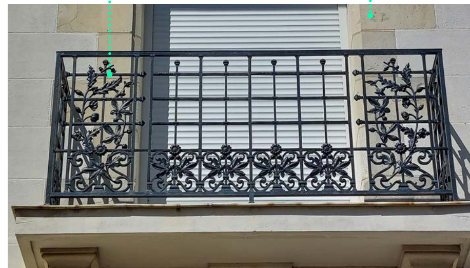
Garde-corps en fer forgé, barreaux, volutes et flores
