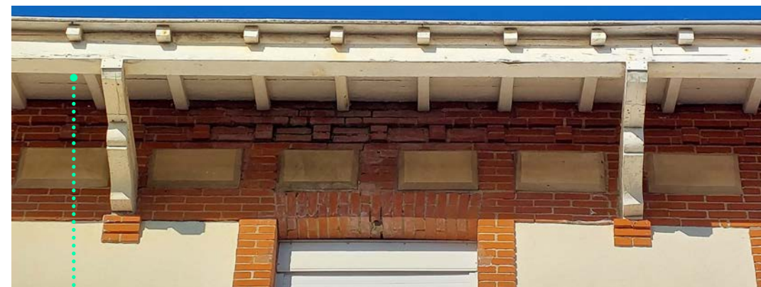
Débord de toiture sur aisseliers
