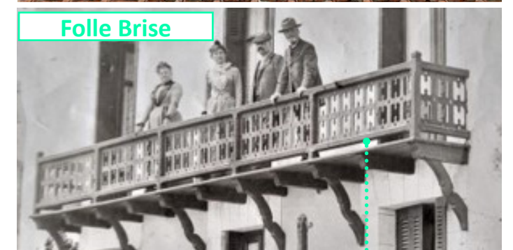
Balcon filant menuisé
