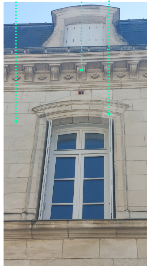
corniche à modillons en consoles à glyphes Parement de pierre de taille (calcaire) Linteau segmentaire
